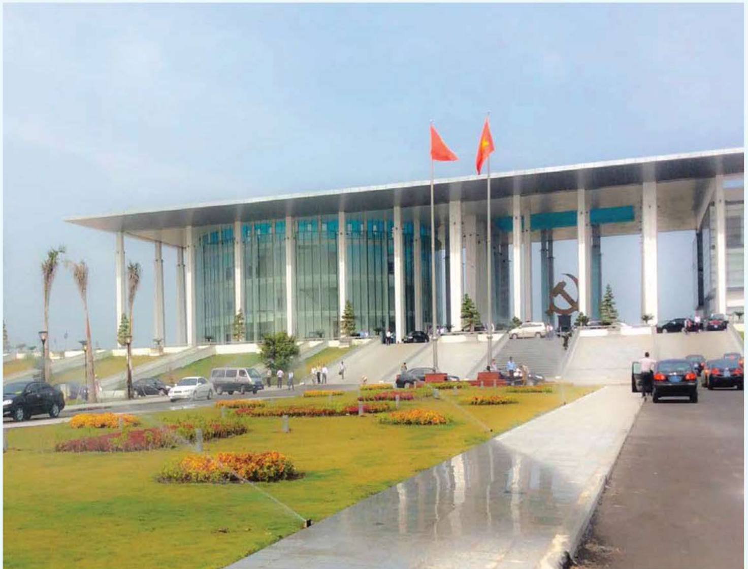
Hệ thống tưới - Công viên khu hành chính Tỉnh Ủy Hậu Giang
