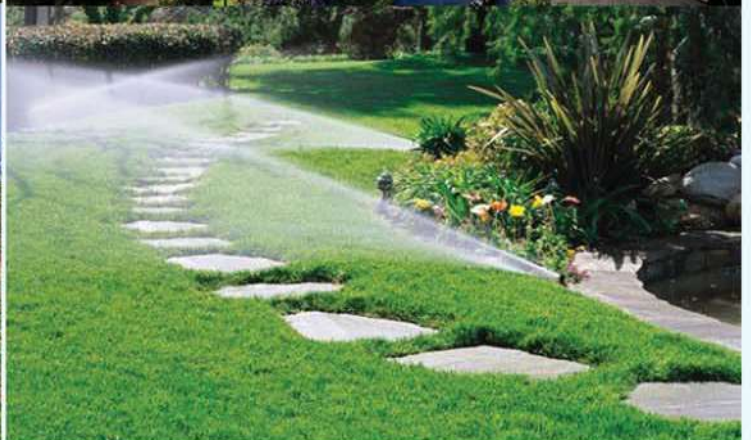
Hệ thống tưới – Resort Pullman Phú Quốc
